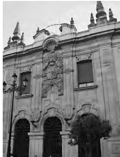
Fachada del edificio de correos de Sevilla. Es obra de Joaquín Otamendi y de Luis Lozano Losilla († Madrid 1973) los dos arquitectos de la Escuela de Conde de Peñalver.
