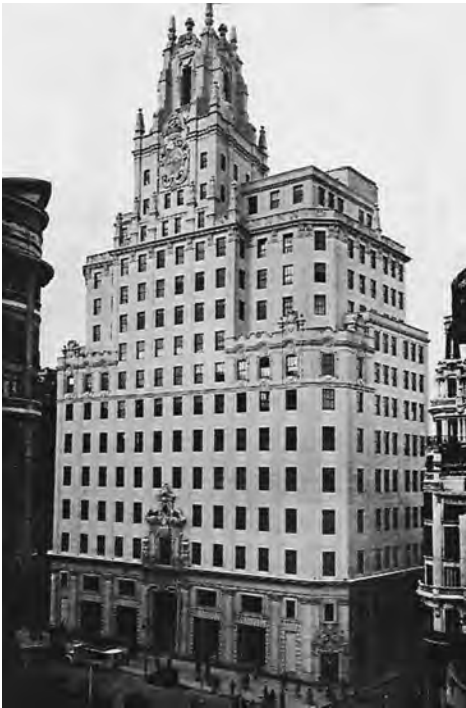
El magnífico edificio de la Telefónica, entonces CTNE, recién inaugurado en 1929. La CTNE se fundó en 1924 y el edificio fue construido entre 1925 y 1929.
